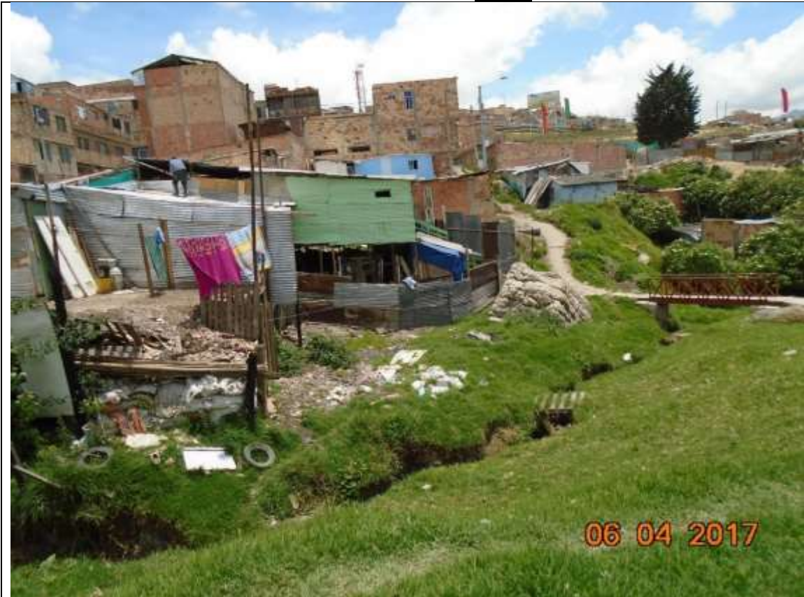
Fotografía N° 11 Box Coulvert X=96480,91 Y=88929,11
