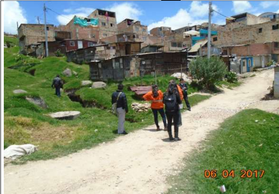
Fotografía N° 9 Box Coulvert X=96555,96 Y=88927,79
