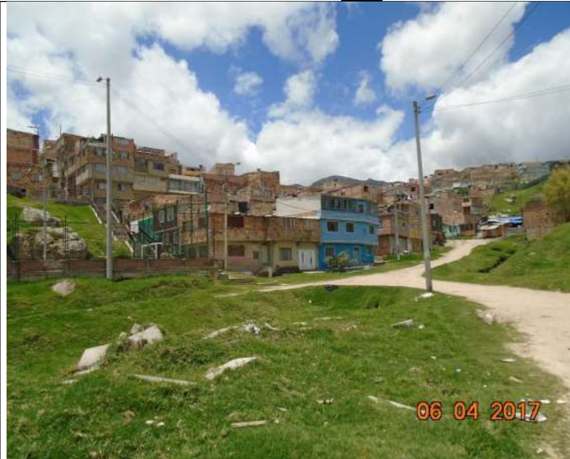
Fotografía N° 12. Box Coulvert X=95960,53 y Y=89081,97
