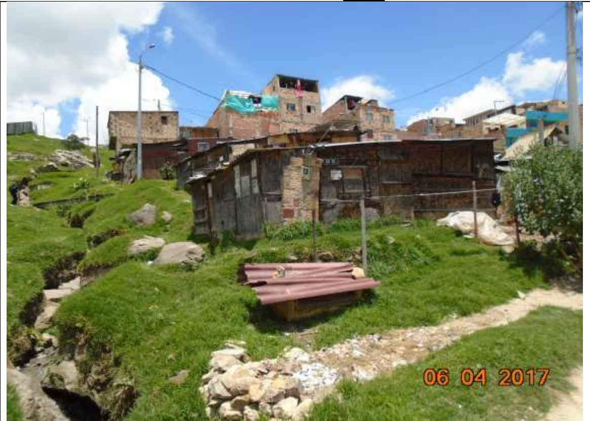
Fotografía N° 10. Box Culvert X=96555,96 Y=88927,79
