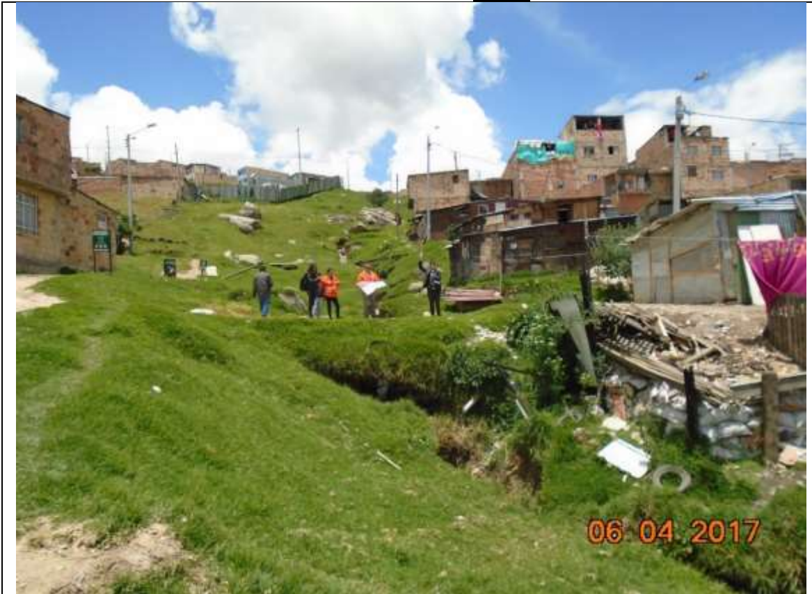
Fotografía N° 8 Box Coulvert X=96184,91 Y=88993,04
