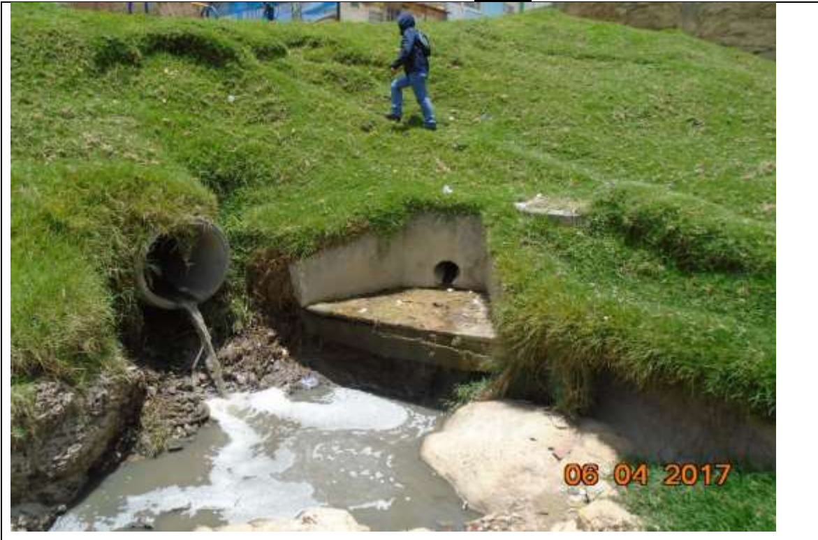
Fotografía N° 5. Punto de Box Coulvert X=95989,95 Y=89073,34
