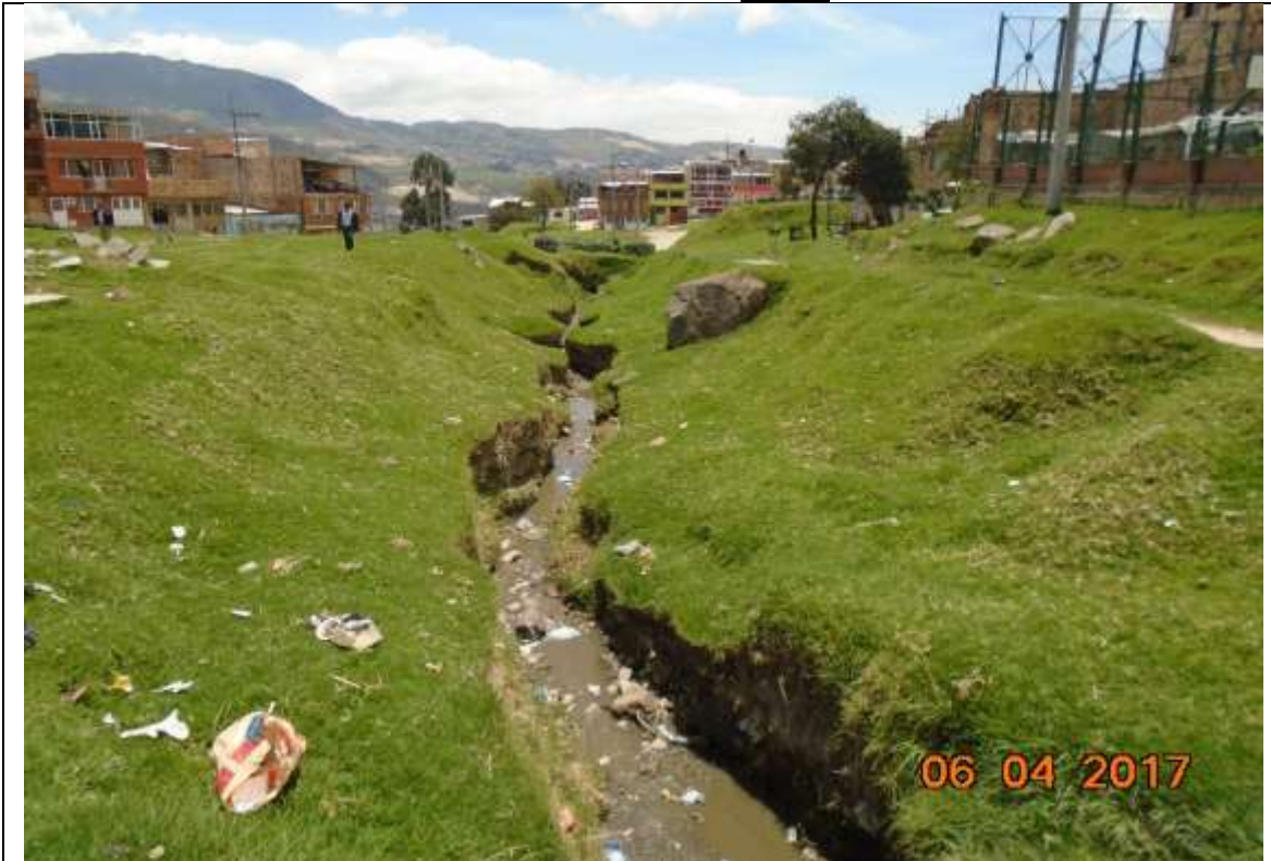
Fotografía N° 2. Dig 98 D sur Kr 3 X=96184,91 y Y=88993,04 georreferenciación de posible construcción de Box Coulvert
